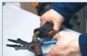
сваляне и инсталиране на газовата дюза
